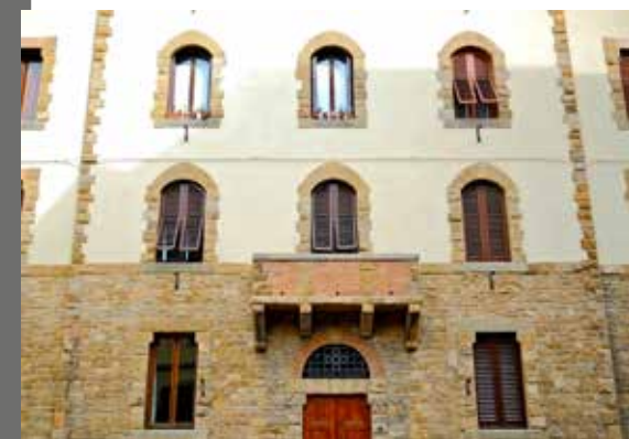
Prospetto di una serie di blocchi di case popolari nelle vie Cesare Guasti, Raffaello Lambruschini, Gaetano Milanese e piazza Giampietro Vieusseux Lavori e servizi pubblici, "100. Case popolari", CF 7582, dis. 80
