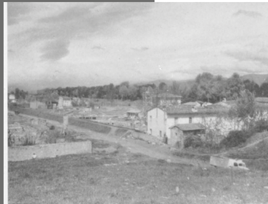
Foto del Comune Come appariva la zona dell'Isolotto prima dell'inizio dei lavori.
